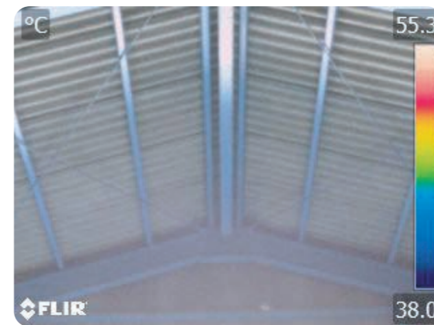
①施工前現況
