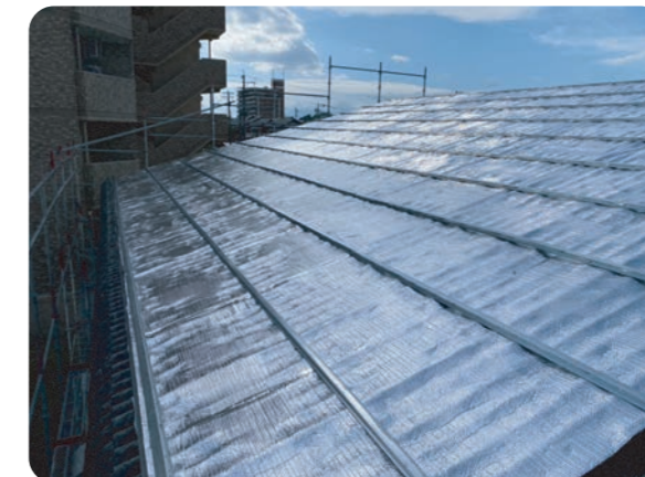
リフレクティックス 施工後
