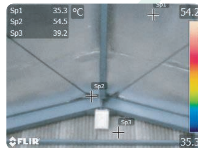
③施工後現況
