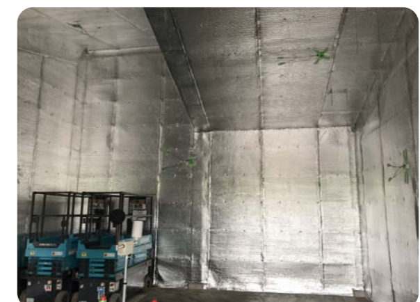
リフレクティックス 施工後
